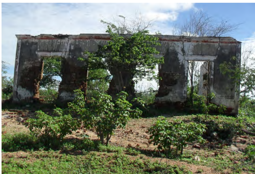
Figura 6 – Ruínas da Fazenda Arara, município de São João do Cariri, construída em meados do século XIX. Fonte: Arquivo do autor.
