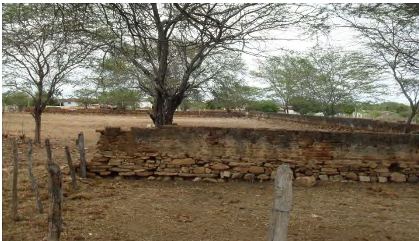
Figura 5 – Curral de pedras e cal da Fazenda Serra Branca. Fonte: Arquivo do autor, em junho de 2014.
