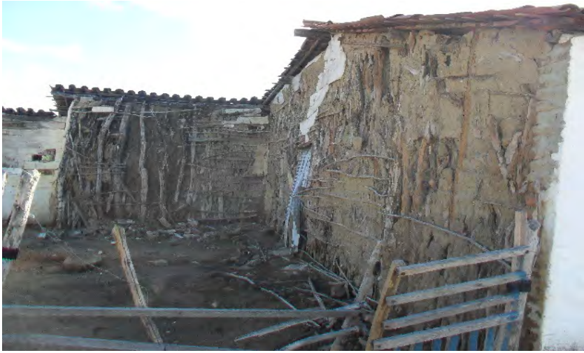
Figura 1 – Ruínas da lateral de uma casa de taipa, no Sítio Curral do Meio. Fonte: Arquivo do autor.
