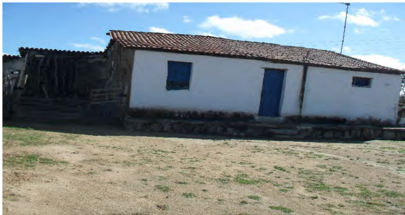
Figura 2 – Casa de taipa com frente reformada, no Sítio Curral do Meio. Fonte: Arquivo do autor.
