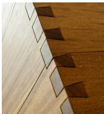
Figura 143: Detalhe do encaixe rabo de andorinha
