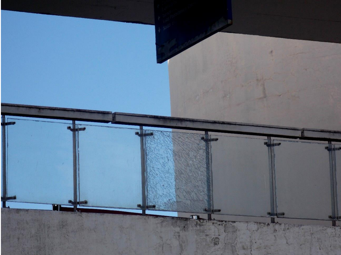
Figura: 15. Detalhe do corrimão da escada da Torre da Estação, 2018.
