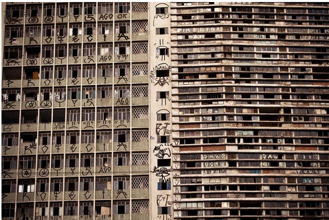
Figura 18 - Fotografia de prédios na cidade de São Paulo em 2017.
