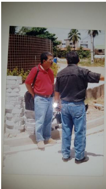
Figura 8 - Douglas Monteiro, então presidente da AMI, nas obras de calçamento do bairro
